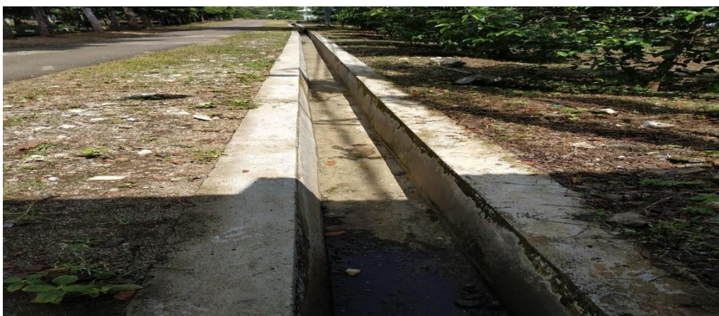
Gambar 4. Jalur instalasi pipa dari bak penampungan ke kebun tanaman obat
