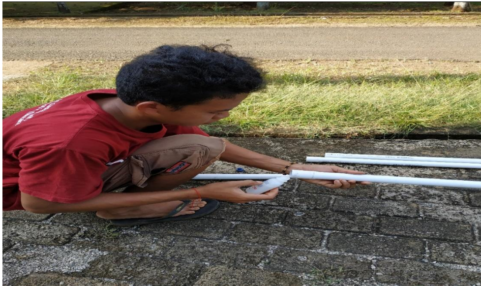
Gambar 5. Persiapan pemasangan pipa instalasi
