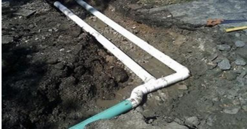
Gambar 2. Contoh pembuatan instalasi pipa saluran air
