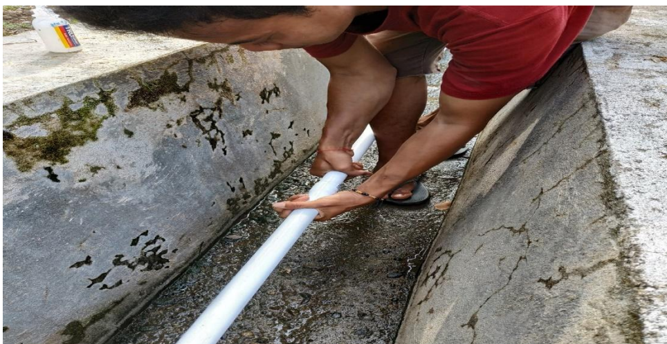
Gambar 7. Pemasangan pipa instalasi
