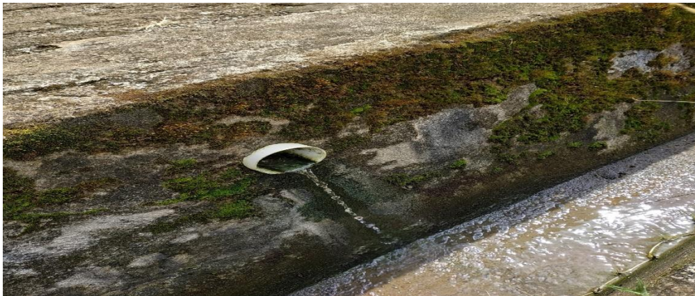
Gambar 3. Persiapan bak penampungan
