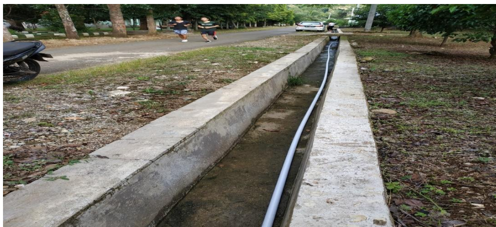
Gambar 8. Pipa instalasi yang sudah terpasang
