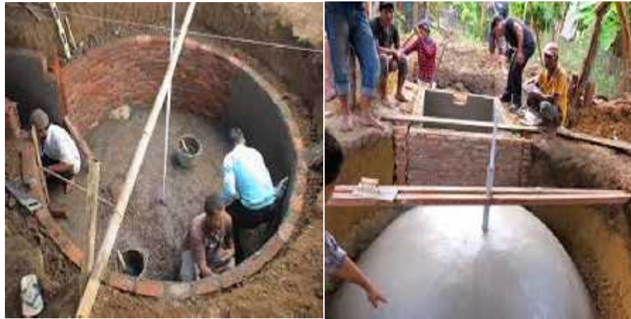
Gambar 7. Pembuatan saluran kotoran dan penutup.
