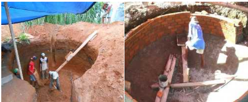
Gambar 6. Penggalan dan pemasangan batu bata.
